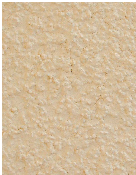
Attēls 5.1. Nekvalitatīva dekoratīvā struktūrapmetuma virsma
